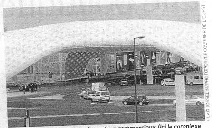
Un million de m 2 de projets de centres commerciaux (ici le complexe Atoll, à Angers) serait programmé pour les mois à venir en France.
