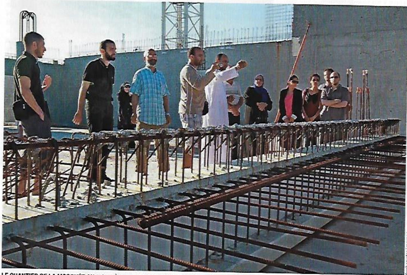
LE CHANTIER DE LA MOSQUÉE AN-NOUR À MULHOUSE en 2012. Cette maison de Dieu grandiose, qui comprendra également une école et des commerces, va coûter 7 millions d'euros. La fondation Qatar Charity l'a financée à hauteur de 2 millions d'euros.
